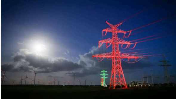
TenneT-Umspannwerk in Klixbüll: Der niederländische Netzbetreiber will sein Stromnetz in Deutschland verkaufen. Der Bund fällt als Käufer aus. © Christian Charisius/dpa
